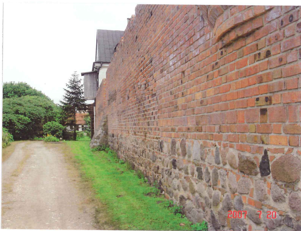
fot.8. Mur północny w widoku od strony zewnętrznej. W głębi przypora kamienna. W górnym rogu zdjęcia widoczny wspornikowo wysunięty mur bastei północno zachodniej.
