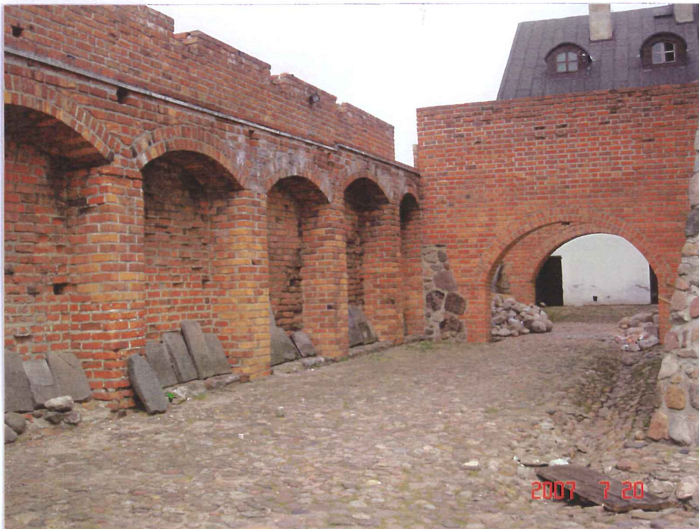
fol.9. Mur północny arkadowy od strony dziedzińca. W głębi widoczne mury poprzeczne z przesklepionymi otworami. Mur bliższy jest wykonany ze współczesnej cegły.
