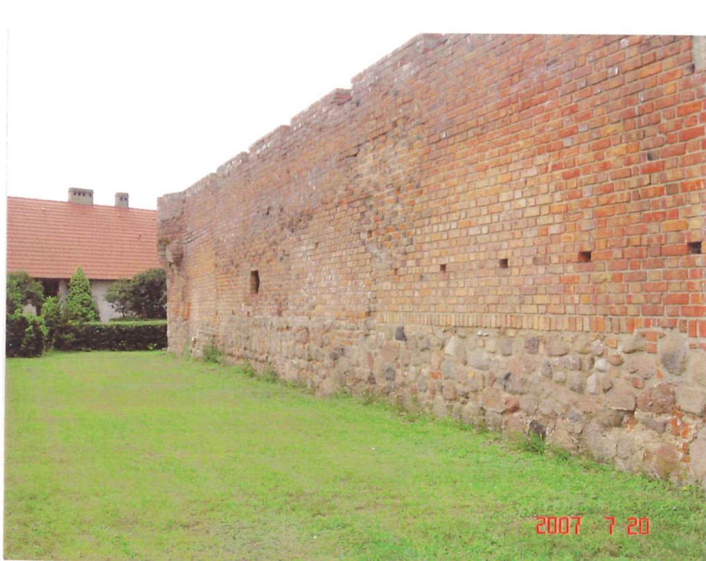
fot.2. Mur południowy w widoku od strony zewnętrznej. W głębi na narożu basteja południowo-zachodnia.
