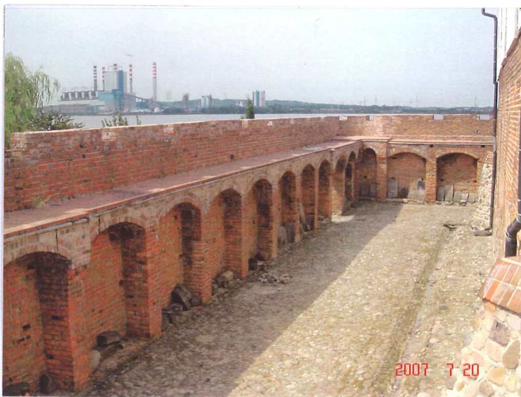
fot.7. Mur zachodni – widoczna korona muru i chodnik obronny. W głębi w narożu murów basteja północno-zachodnia. Chodnik obronny o posadzce ze współczesnej cegły, położonej w spadku.
