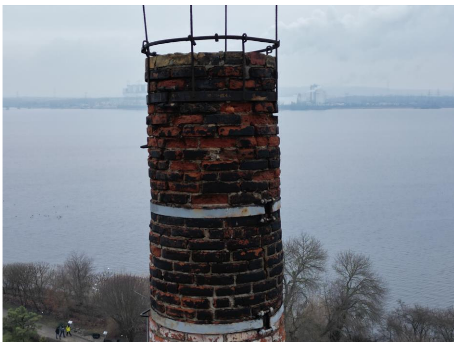
Fot. 10 – Widok na zwieńczenie komina – widoczne iglice instalacji odgromowej przeznaczone do odtworzenia..
