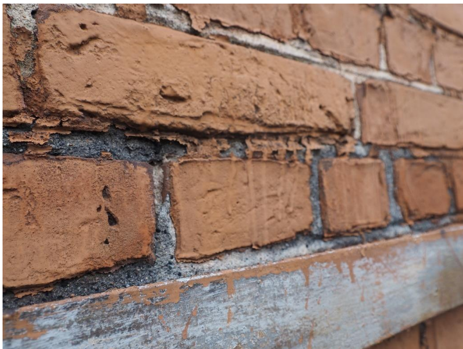
Fot. 31 – Łuszcząca się farba w dolnej części komina.
