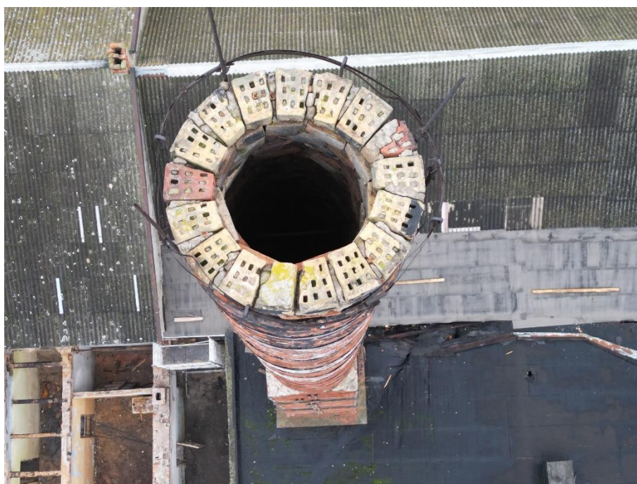
Fot. 14 – Widok od góry na koronę komina – szczegół. Widoczny brak przekrycia,
