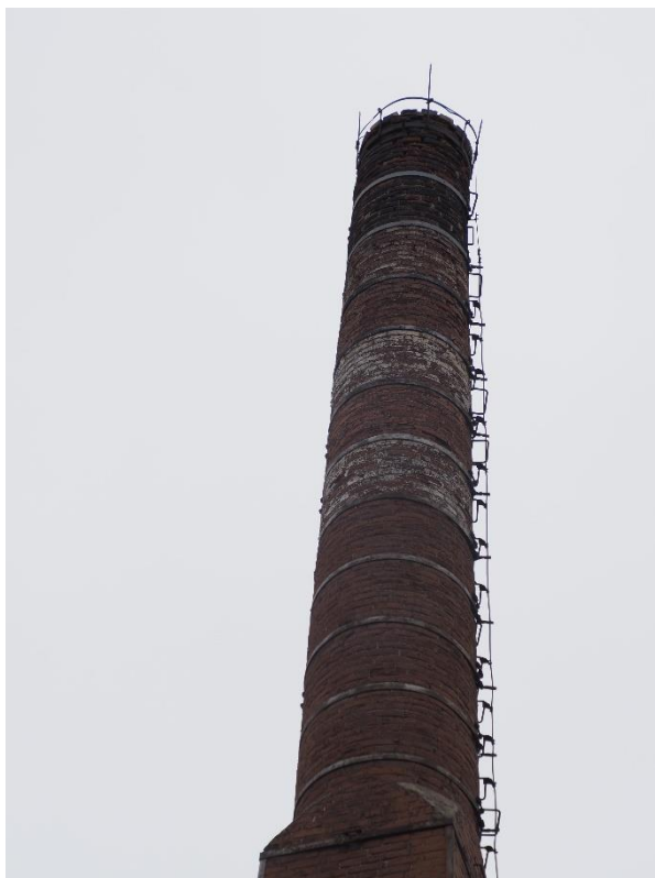
Fot. 5 – Widok od dołu na górną część komina - przeznaczoną do rozebrania i odbudowy.
