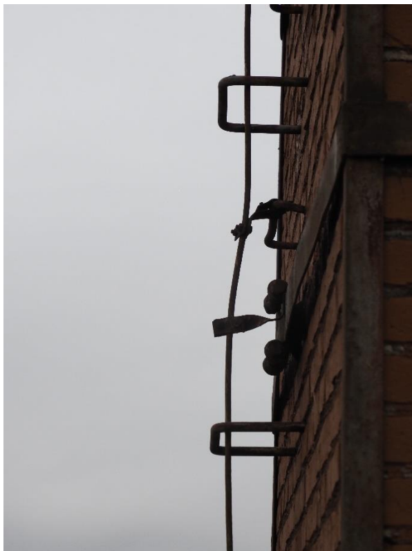
Fot. 18 – Klamry stalowe służące do wyjścia na górę komina oraz instalacja odgromowa - szczegół.
