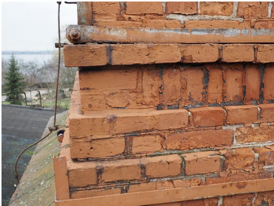
Fot. 29 – Łuszcząca się farba w dolnej części komina.
