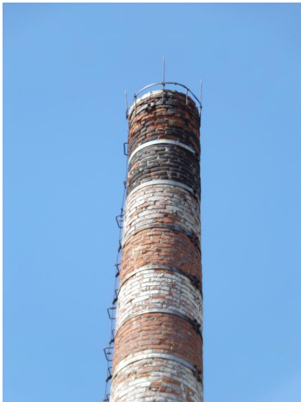
Fot. 7 – Widok od dołu na górną część komina - przeznaczoną do rozebrania i odbudowy.
