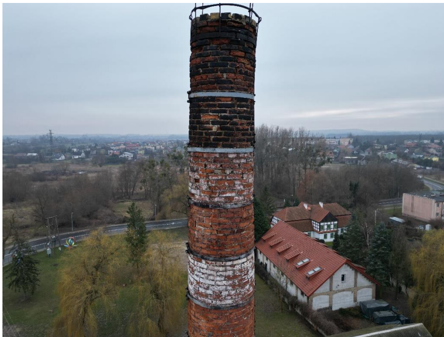
Fot. 8 – Widok na najbardziej uszkodzoną część komina - przeznaczoną do rozebrania i odbudowy.
