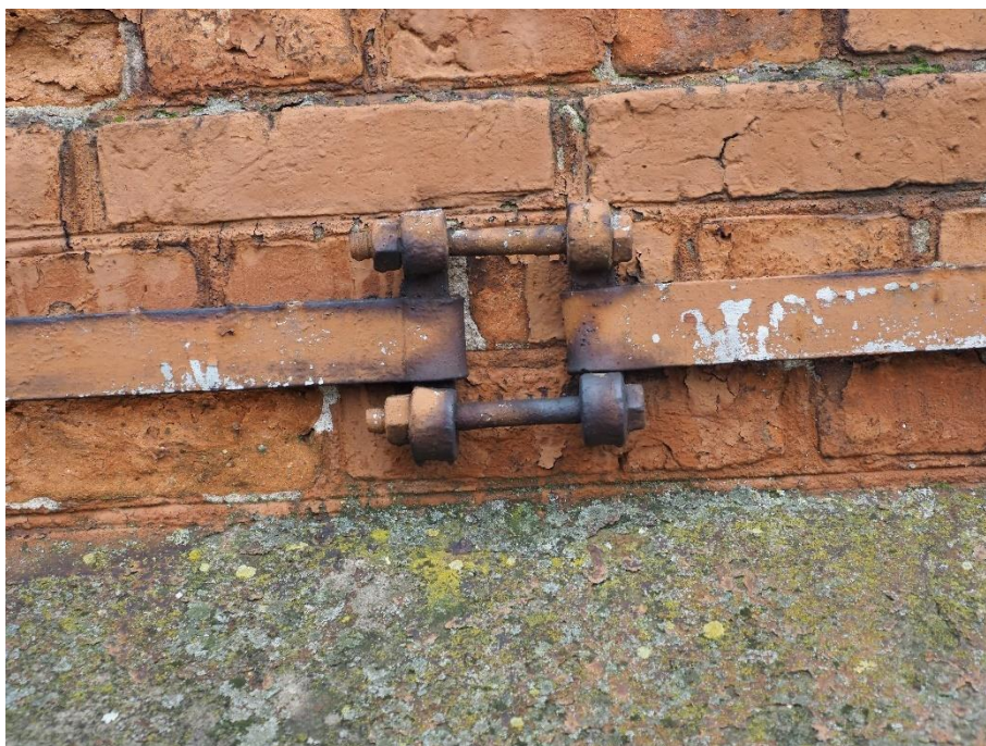
Fot. 32 – Szczegół połączenia obejmy stalowej.
