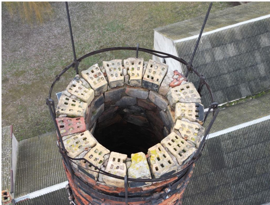
Fot. 15 – Widok na koronę komina. Widoczny brak przekrycia,
