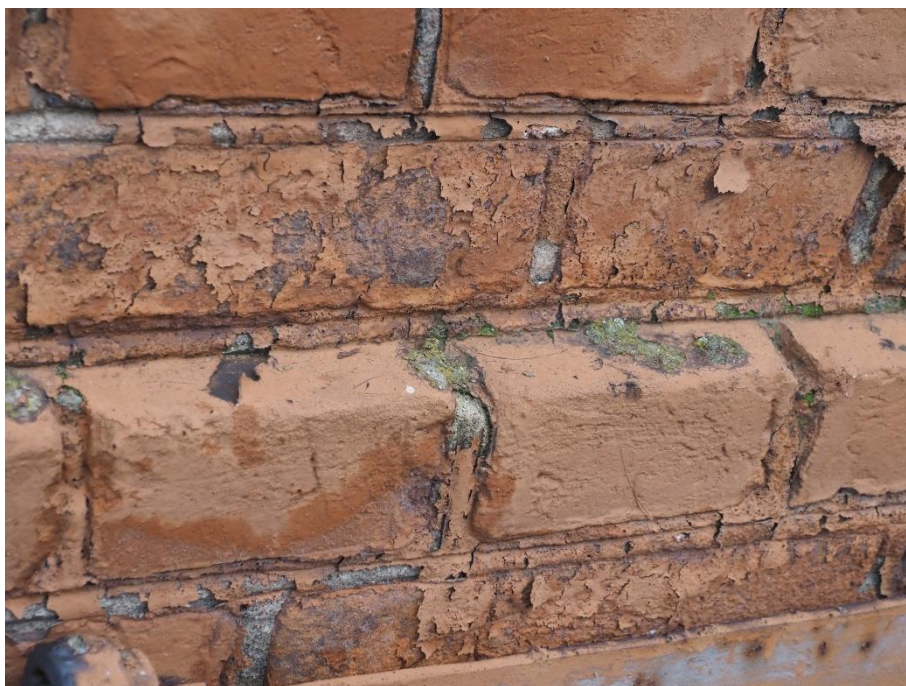
Fot. 30 – Łuszcząca się farba w dolnej części komina.
