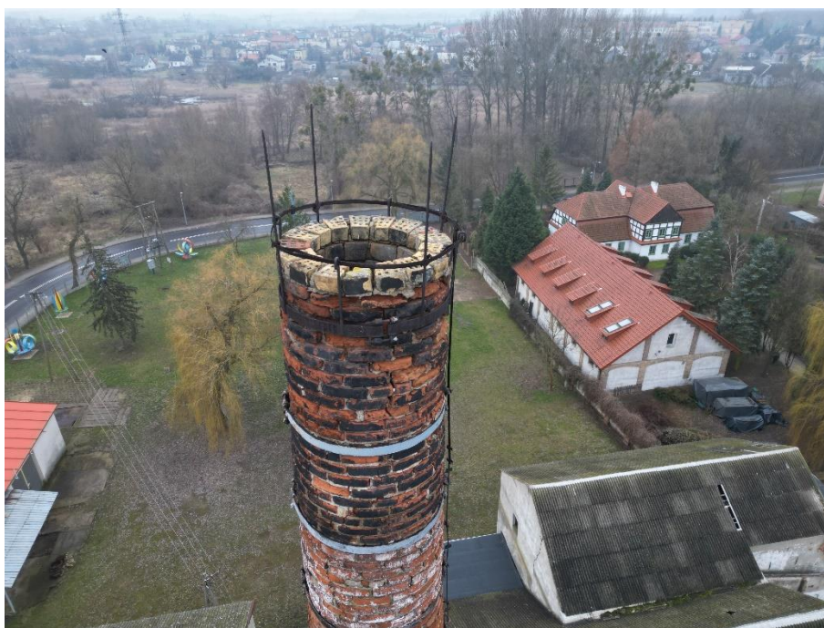
Fot. 12 – Widok na zwieńczenie komina – widoczne iglice instalacji odgromowej przeznaczone do odtworzenia...
