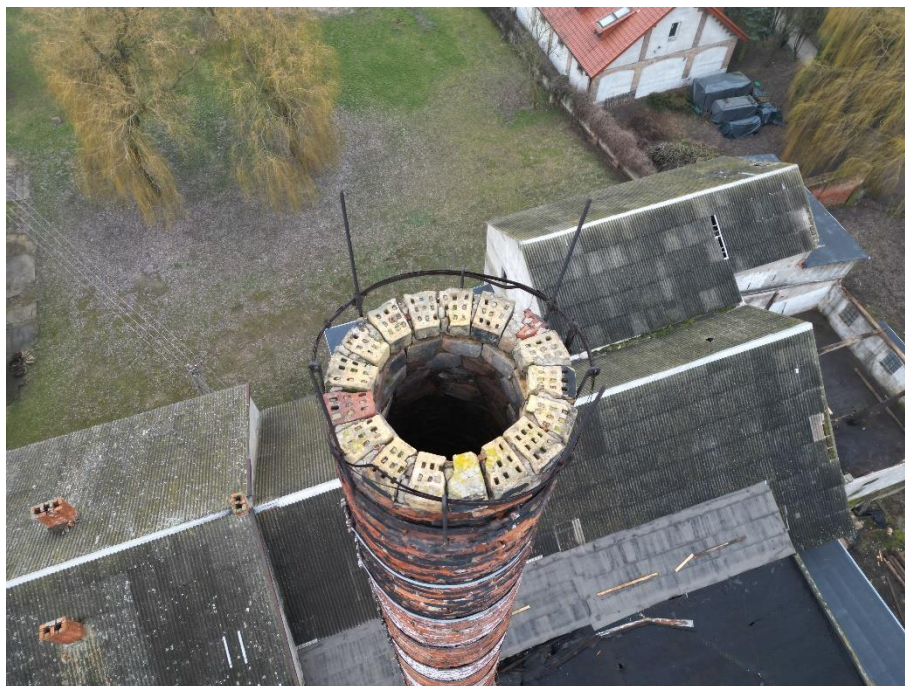
Fot. 13 – Widok na zwieńczenie komina – widoczne iglice instalacji odgromowej przeznaczone do odtworzenia. Widoczny brak przekrycia komina.
