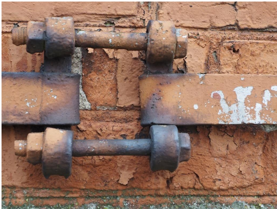
Fot. 33 – Szczegół połączenia obejmy stalowej.
