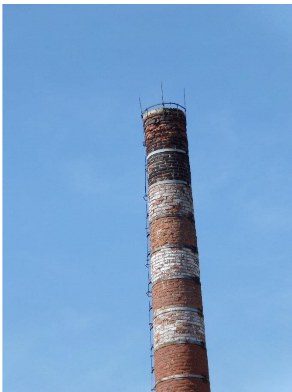
Fot. 6 – Widok na górną część komina - przeznaczoną do rozebrania i odbudowy..
