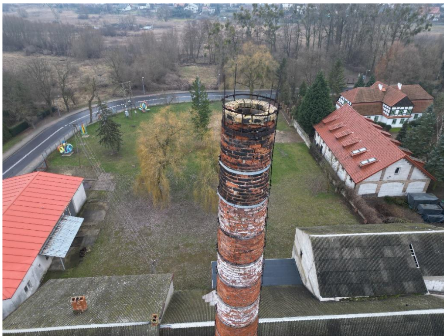
Fot. 11 – Widok na zwieńczenie komina – widoczne iglice instalacji odgromowej przeznaczone do odtworzenia...
