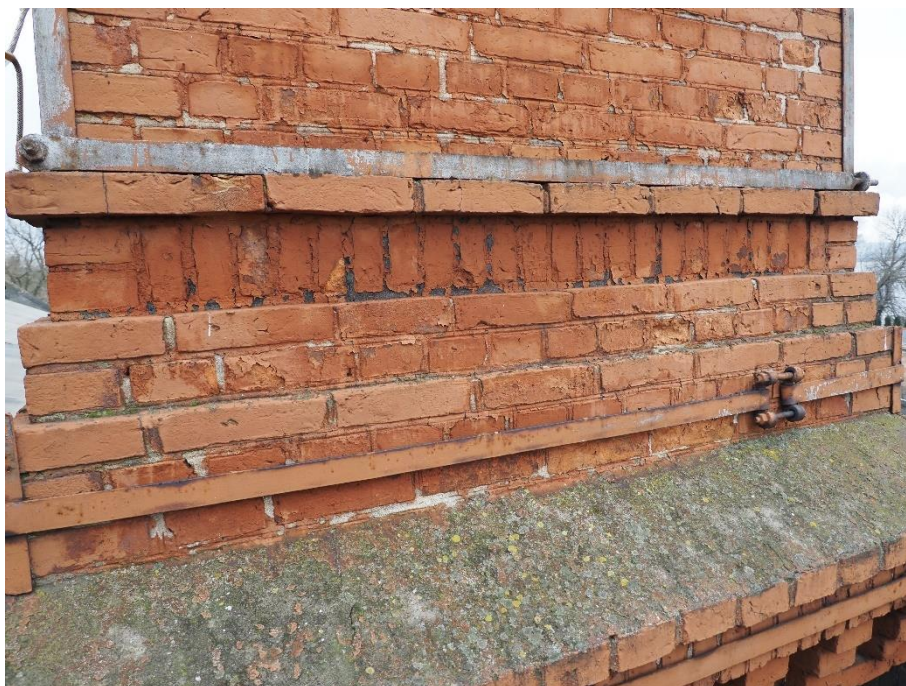
Fot. 28 – Łuszcząca się farba w dolnej części komina.
