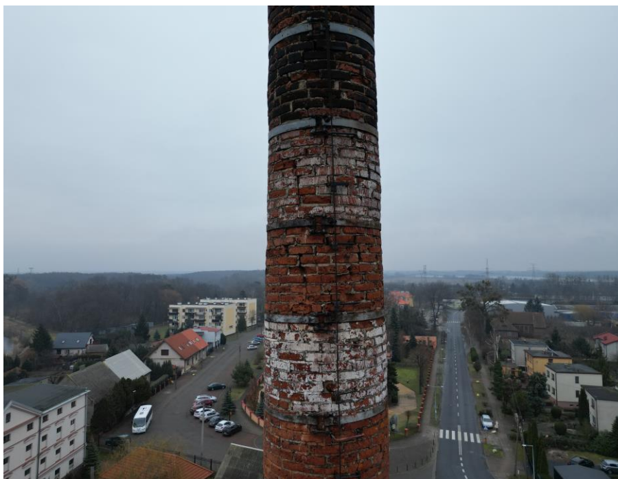
Fot. 16 – Widok na najbardziej zniszczoną część komina.
