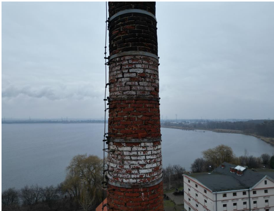
Fot. 17 – Widok na najbardziej uszkodzoną część komina.
