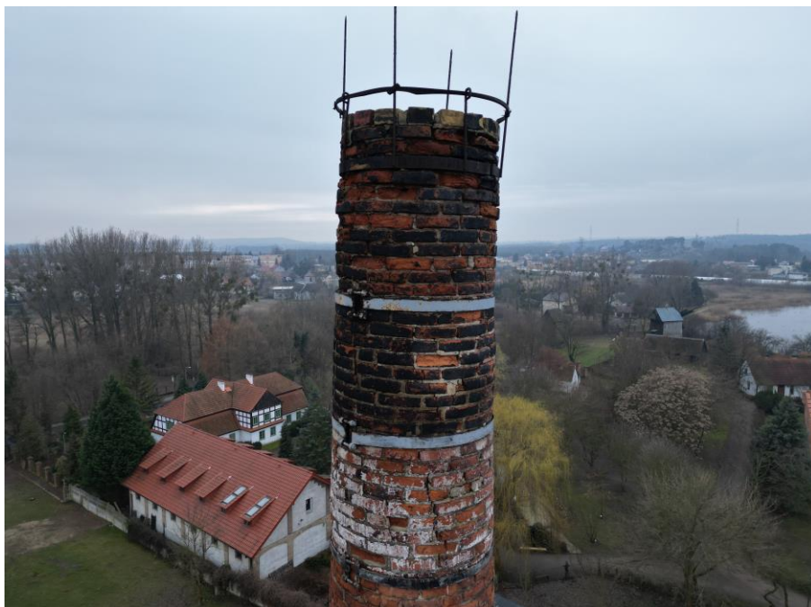
Fot. 9 – Widok na zwieńczenie komina – widoczne iglice instalacji odgromowej przeznaczone do odtworzenia..
