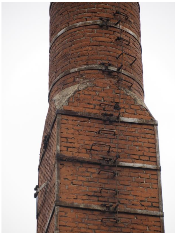
Fot. 19 – Widok na miejsce zmiany geometrii komina.
